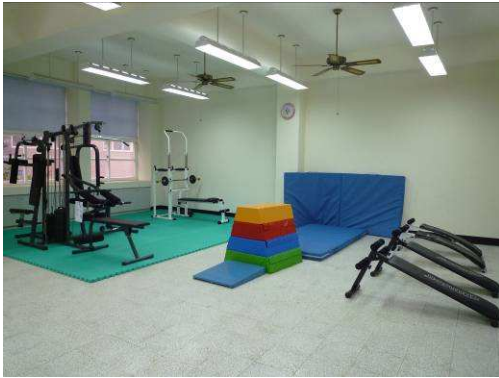
說明： 施工後一體適能運動站健身器材設置
