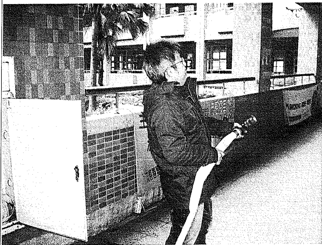
滅火班班長演練消防栓之操作
